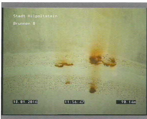
Foto: 2_16A 90,14m, beginnende Korrosion
