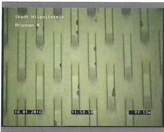
Foto: 2_19A 99,12m, Filterkies sichtbar
