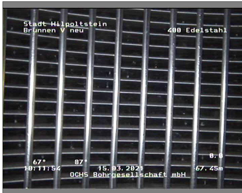
Foto: 101450_A.JPG, 00:13:26 67,45m, Filterschlitzte offen, Glaskugeln sichtbar
