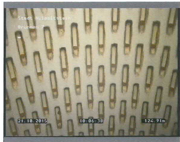
Foto: 2_45A 124,91m, Filterschlitze offen
