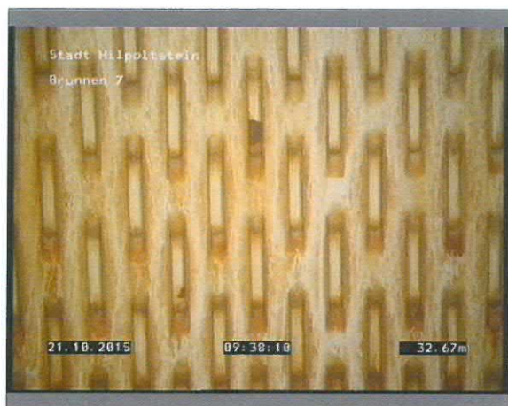
Foto: 2_15A 32,67m, Filterschlitz offen
