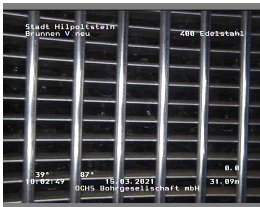
Foto: 100545_A.JPG, 00:04:54 31,09m, Filterschlitzte offen, Glaskugeln sichtbar
