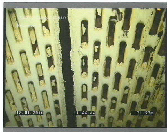
Foto: 2_8A 31,93m, Filterschlitzte offen
