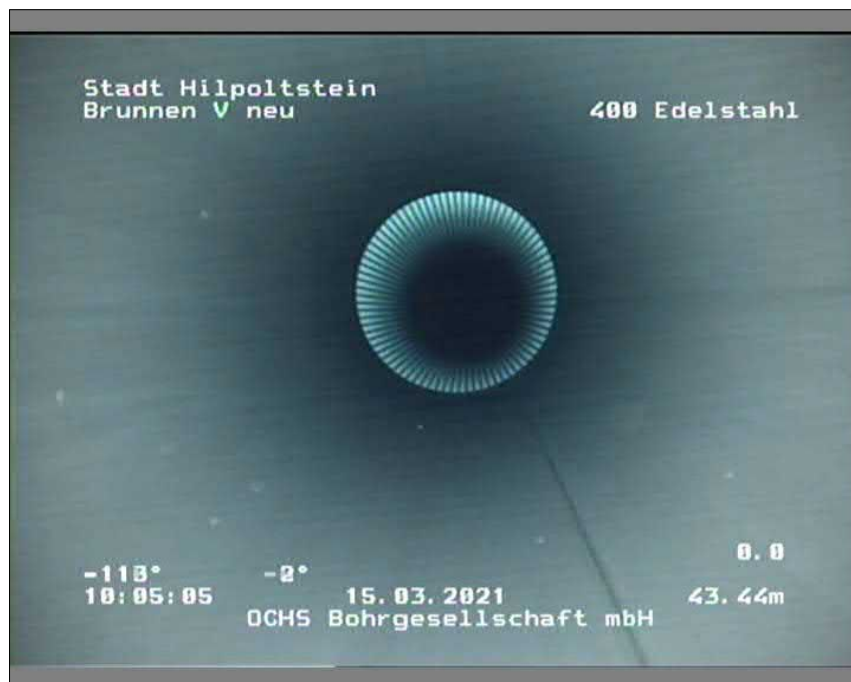
Foto: 100801_A.JPG, 00:07:01 43,44m, Blick ins Vollrohr, abgelagerungsfrei
