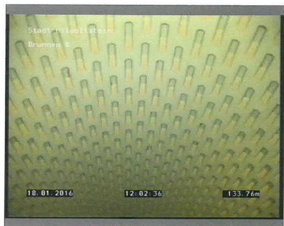
Foto: 2_20A 133,76m, Filterschlitz offen
