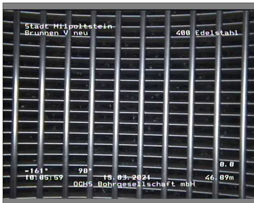
Foto: 100855_A.JPG, 00:07:49 46,09m, Filterschlitz offen, Glaskugeln sichtbar
