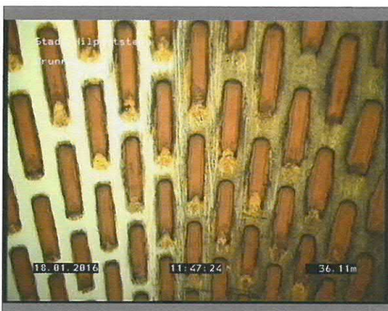
Foto: 2_9A 36,11m, Filterschlitzte offen
