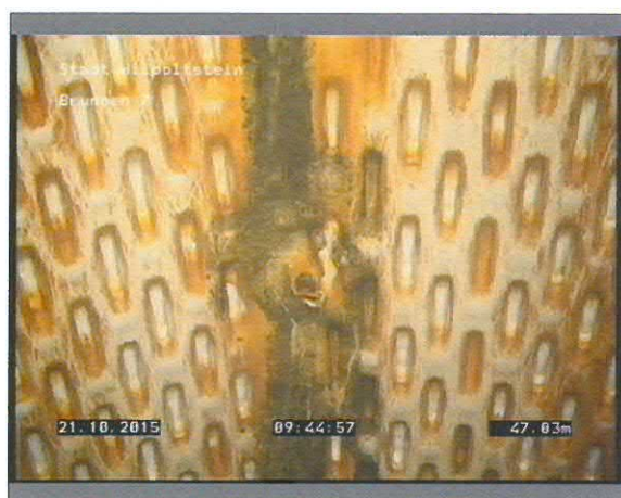
Foto: 2_20A 47,03m, Korrosion, Verkrustung
