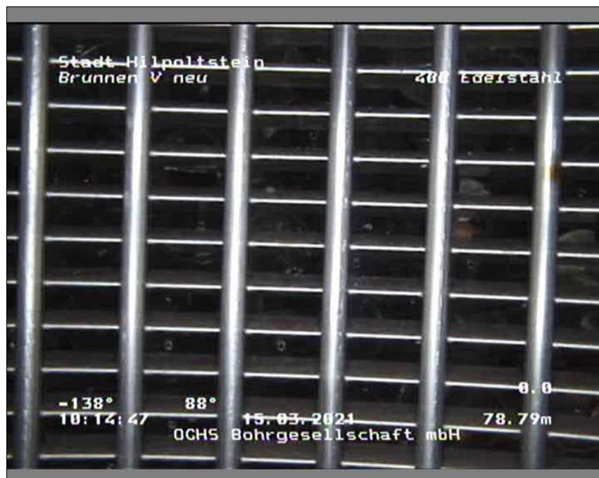
Foto: 101743_A.JPG, 00:16:10 78,79m, Filterschlitzte offen, Glaskugeln sichtbar
