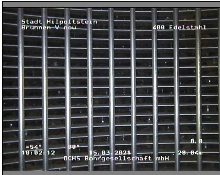
Foto: 100509_A.JPG, 00:04:19 28,04m, Filterschlitzte offen, Glaskugeln sichtbar
