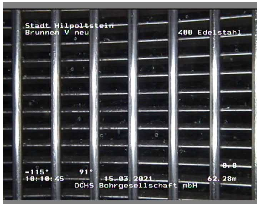
Foto: 101341_A.JPG, 00:12:19 62,28m, Filterschlitz offen, Glaskugeln sichtbar
