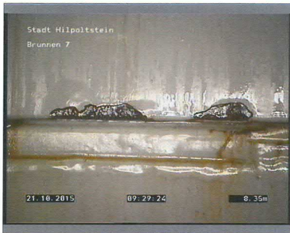
Foto: 2_5A 8,35m, Rohrverbindung mit Korrosion
