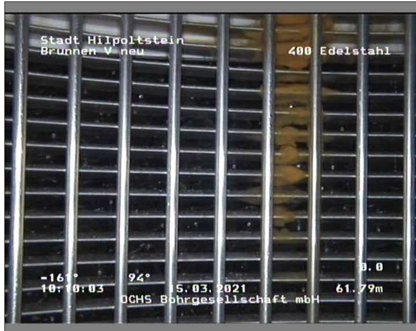
Foto: 101259_A.JPG, 00:11:40 61,79m, Filterschlitz offen, Glaskugeln sichtbar, kleine Verockerung
