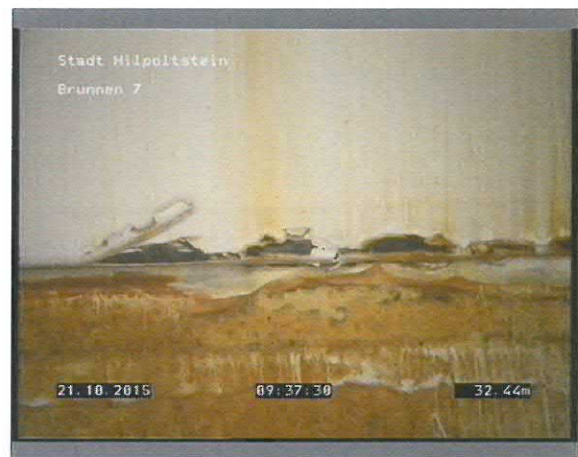
Foto: 2_14A 32,44m, Beschichtung blättert ab
