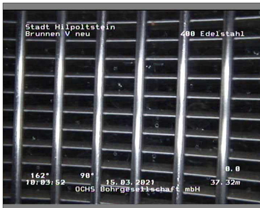
Foto: 100648_A.JPG, 00:05:53 37,32m, Filterschlitz offen, Glaskugeln sichtbar
