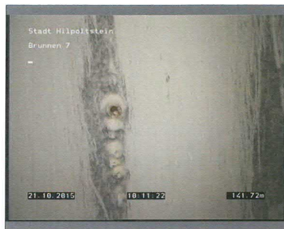
Foto: 2_50B 141,72m, Schweißnaht mit Korrosion
