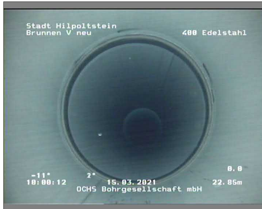
Foto: 100309_A.JPG, 00:02:30 22,85m, Blick ins Vollrohr, ablagerungsfrei
