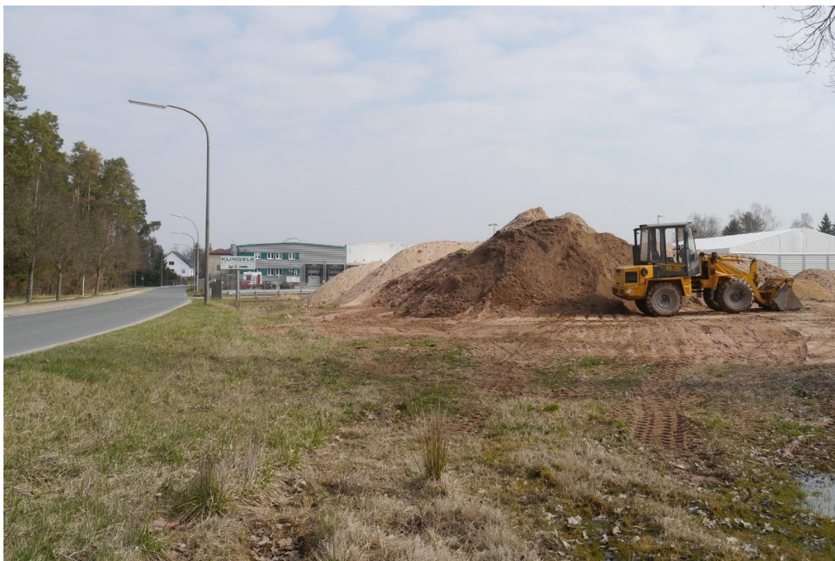
Abb. 4: Nordrand von Flur 164 entlang der Hofstetter Hauptstraße. Aufnahmedatum: 19.03.2020.
