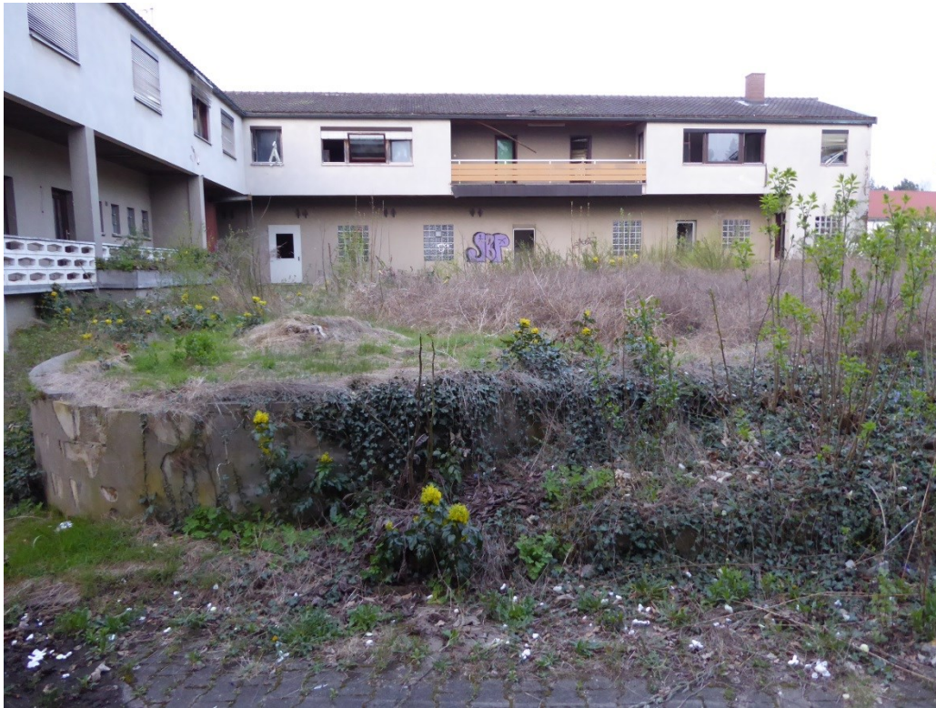
Gebäude und Außenanlagen an der Industriestraße.
