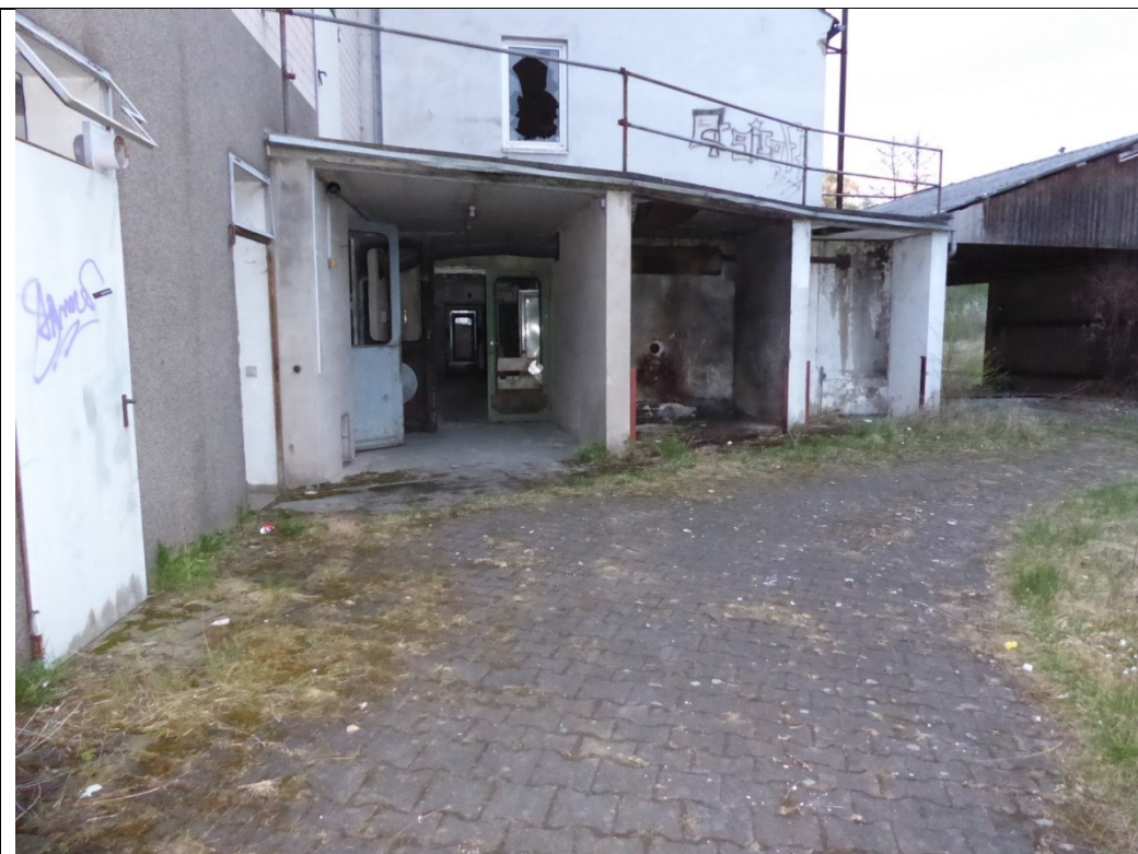
Rund-Gebäude mit offenem Keller: ungeeignet als Winterquartier für Fledermäuse
