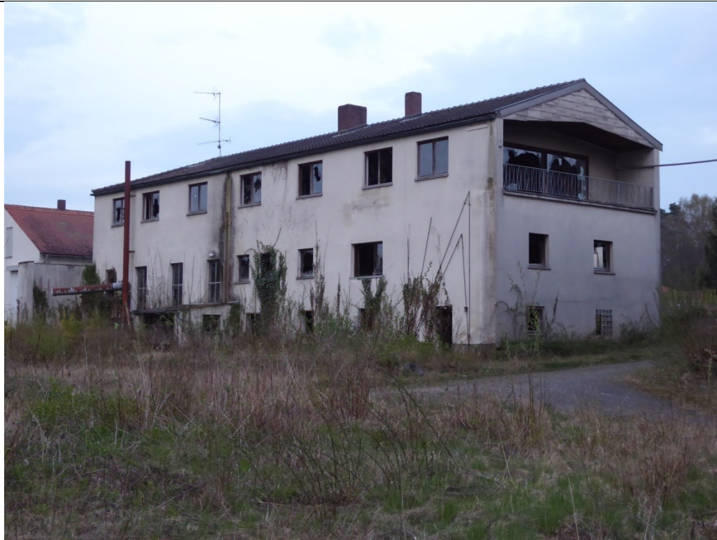
Gebäude mit vielen eingeschlagenen Fenstern: ungeeignet als Sommerquartier für Fledermäuse (zugig, lichtdurchflutet)
