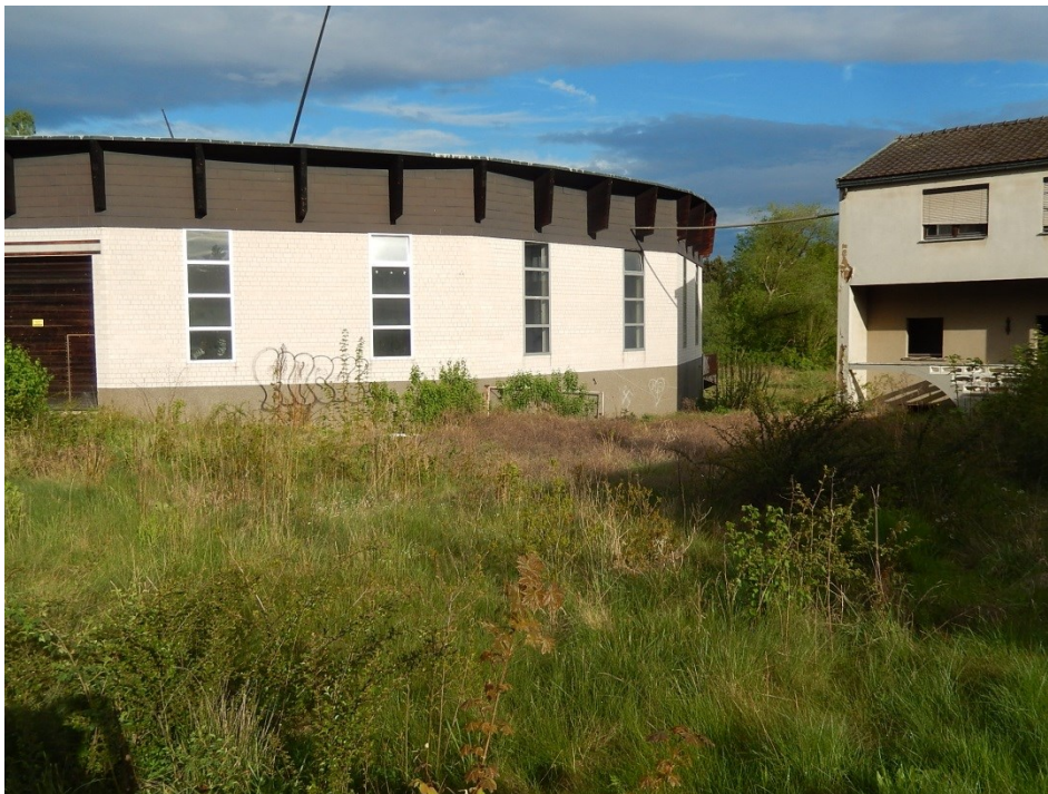
Rundes Gebäude mit Schieferplatten-Verkleidung: potenzielle Spalten-Quartiere
